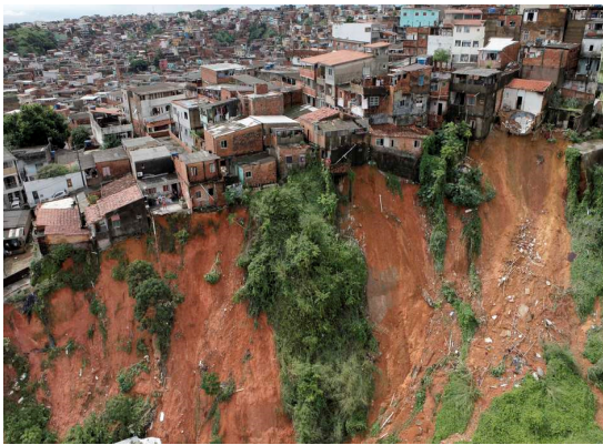
Deslizamento de terra.
